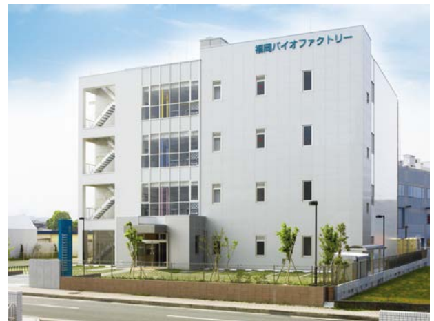
入居している福岡バイオバイオファクトリーの外観
